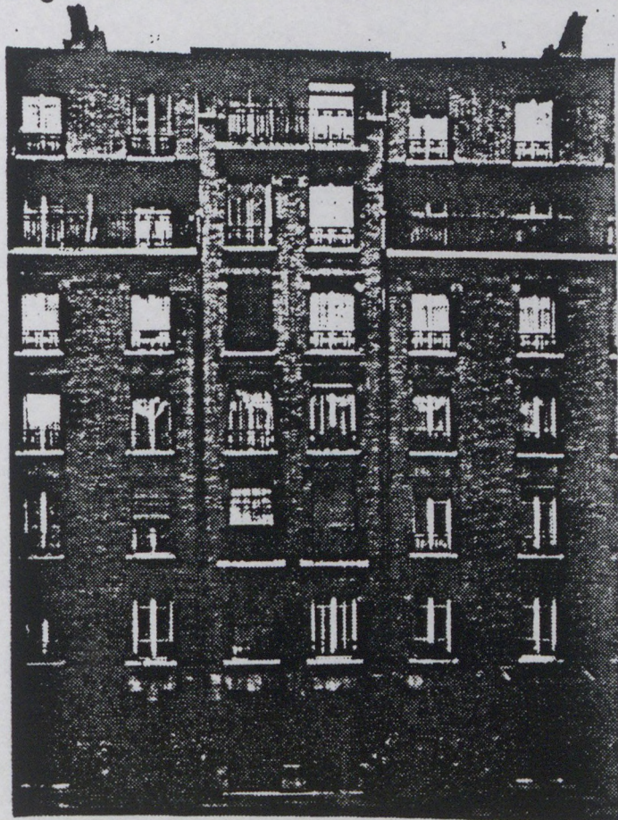
Façade du côté de la rue du Charolais
