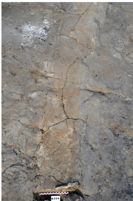
■ Fig. 12 : Vue de détail de la mise en oeuvre de la base de mur en bauge MR53638, dans la partie méridionale de l'UNF139.
