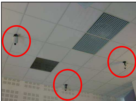
Figure 25 : Offsats au plafond
