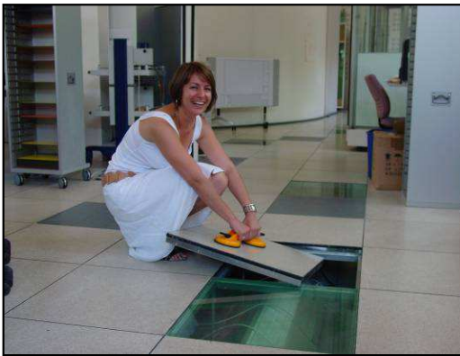
Figure 19 : LDC : dalles du plancher technique
