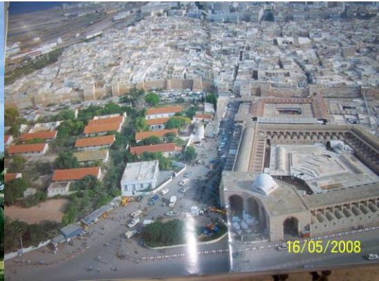
Fig4 : Vue générale des remparts de Sfax
