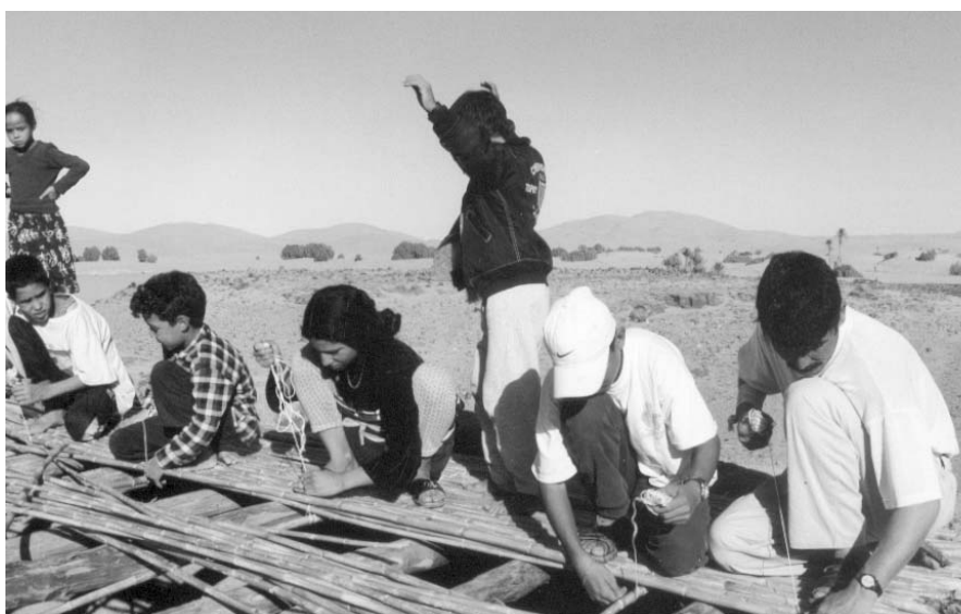
Figure 3. Construction d'une terrasse. Village de Taqucht (cliché M.-L. Gélard, 2003).
