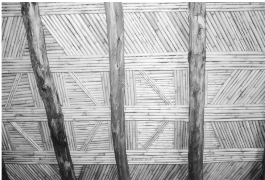
Figure 2. Toiture en roseaux vue de l'intérieur, village d'Hassy Lbyed (cl. M.-L. Gélard, 2005).
