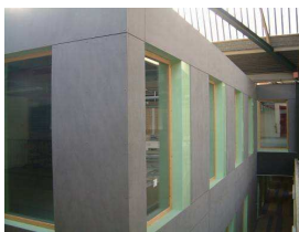
Figure 1 : Vue face intérieur du bâtiment rénové et shed
