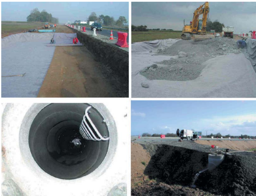
figure 8 Réalisation de la chaussée instrumentée RD767 (couche de forme MIOM).
