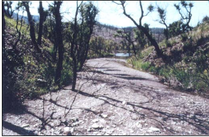
Photo 7 - Dépôts grossiers en amont de la retenue du Gageai 1 (printemps 1991).
