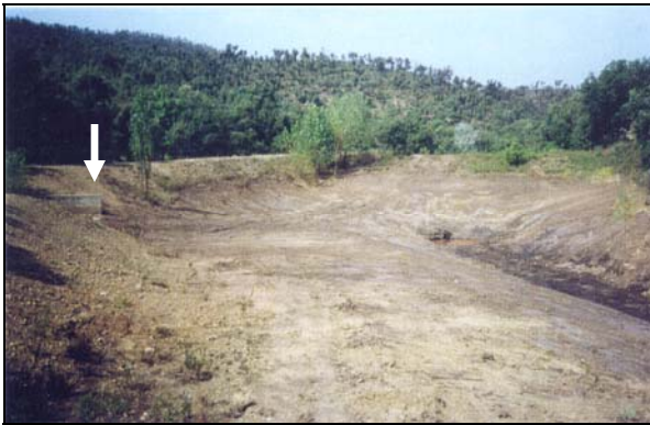
Photo 8 - La retenue du Gageai 1 après curage, en automne 1992 ; le déversoir (flèche) n'est pas très haut par rapport au fond de la retenue.
