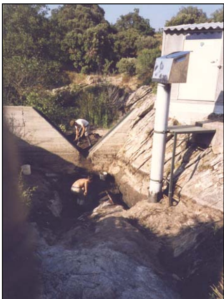
Photo 1 - Station du Rimbaud en cours de curage en septembre 1991.
