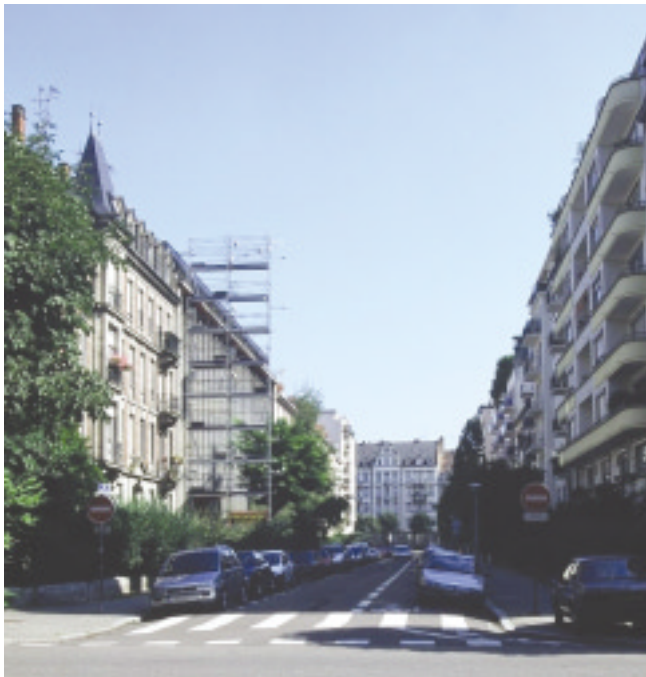
▲ Figure 1 : Echafaudage mis en place rue de l'Argonne (Strasbourg).
