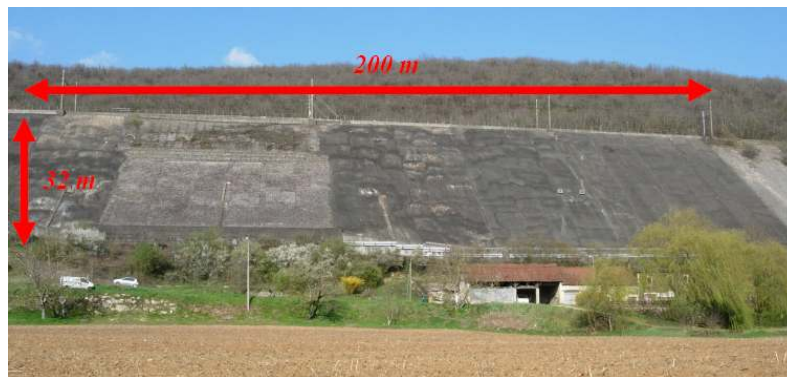
Abb. 8: Das Testobjekt : der Bahndamm in Souillac (Frankreich)
