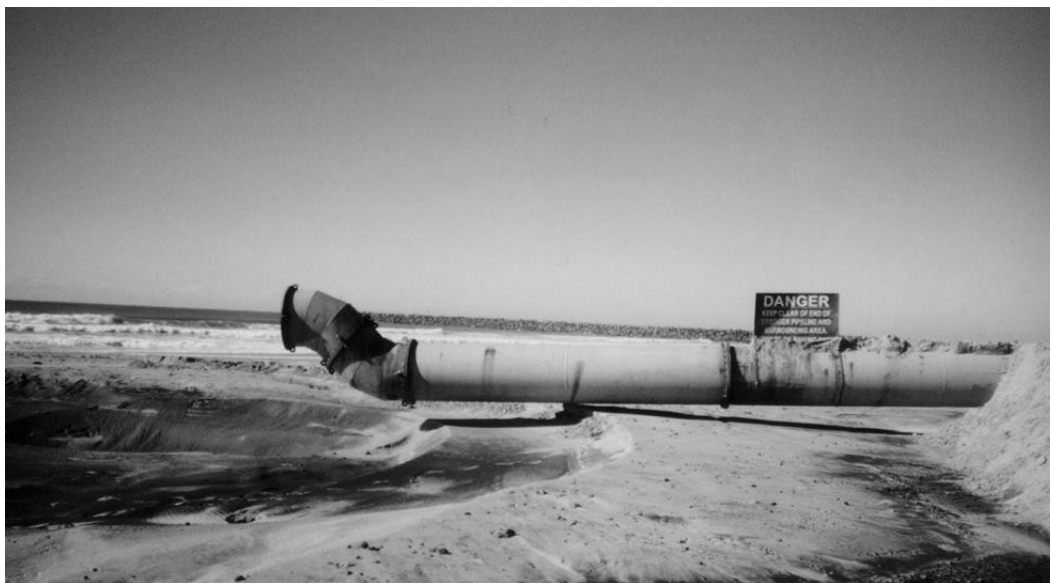
Figure 2 : Exutoire de la conduite de dragage qui ramène sur la plage publique d'Alkanstrand les eaux polluées et sablonneuses de l'entrée du port. En raison de l'érosion très forte due aux digues portuaires piégeant la dérive littorale, cette conduite permet l'engraissement régulier de la plage. (cliché de l'auteur, février 2002).
