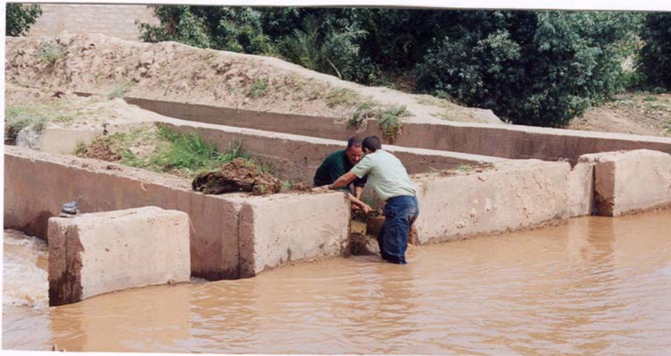
Photo II-3 : Dépôt des gros végétaux puis des mottes de terre pour l'obturation d'une dérivation
