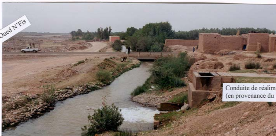
Photo I-1 : Réalimentation d'une seguia par les eaux du barrage Lalla Takerkoust
