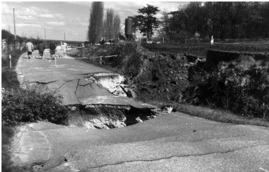
Effondrement de terrain au-dessus d'une carrière souterraine abandonnée
