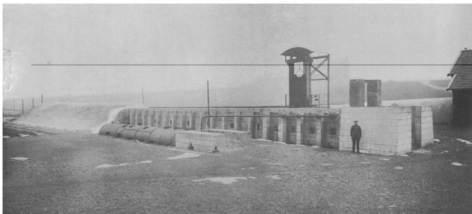
Vue de la galerie des poussières de Liévin vers 1910 (in Taffanel, 1909)
