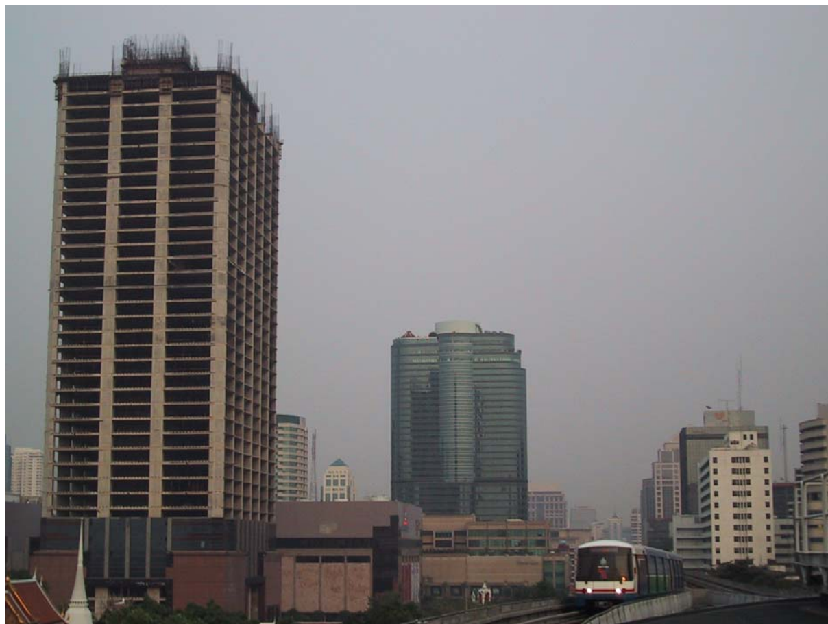
Un des nombreux immeubles dont la construction a été abandonnée après la crise (cliché pris en 2001)
