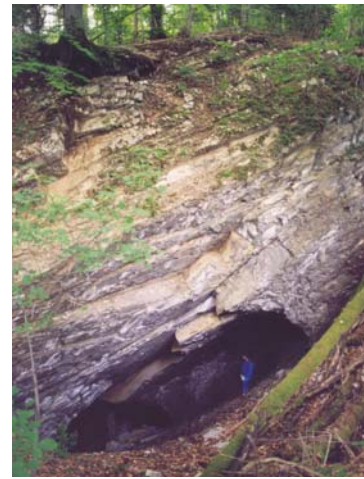
Figure 5 : Rupture d'une tête de veine pentée – effondrement en forme de « tiroir »
