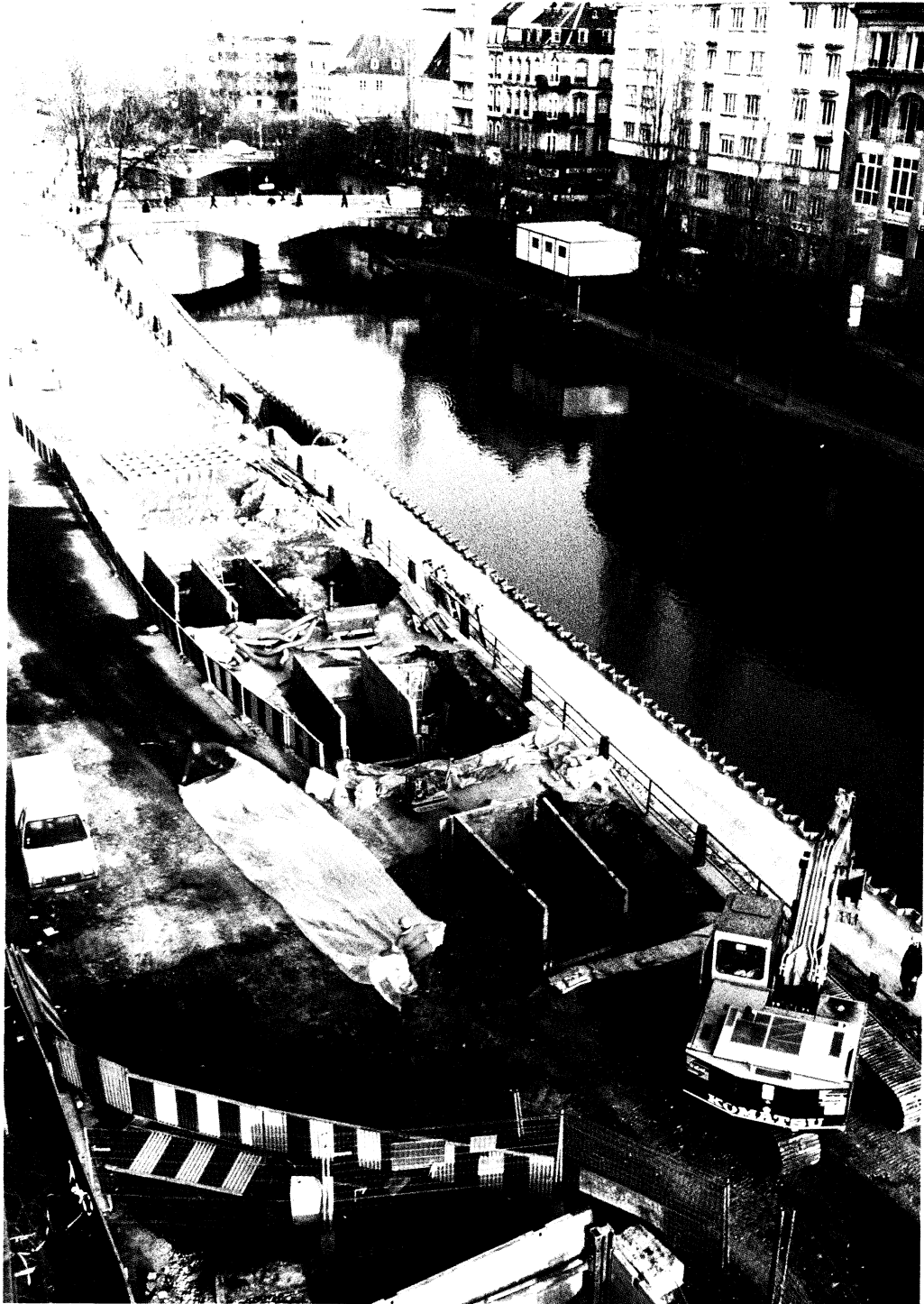
Le quai Kléber en cours de fouille (Photo F. Schneikert).
